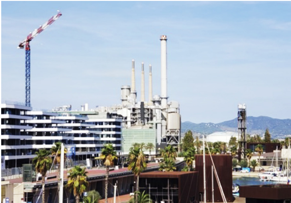
Entorno y planta de valorización energética (TERSA), junto a la generación de energía eléctrica, hay aprovechamiento térmico para suministrar vapor a la red urbana de calor y frío del Forum de Barcelona y del Distrito 22
